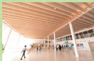
富士山静岡空港 新国内線ターミナル 県産材の梁が外部のひさしまで伸びるデザイン。天竜杉と共に、大井川の木も使用されています。
